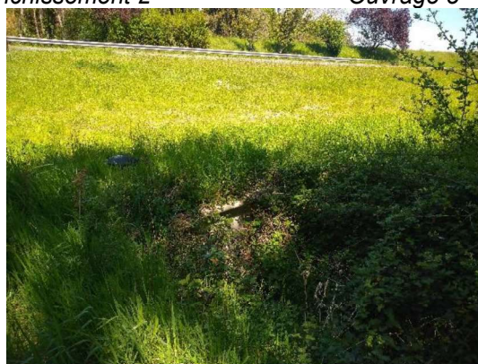
Ouvrage 6 – Aval du projet - Buse DN 500
